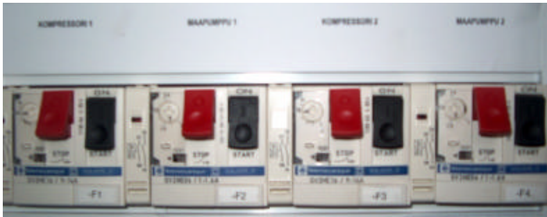
Kuva 14. Moottorinsuojakytkimet
